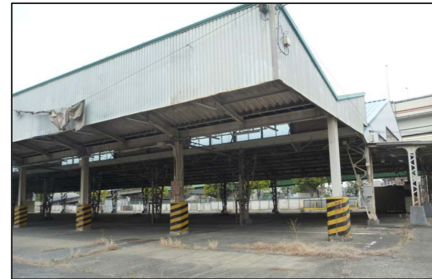
現況写真（市場主棟）
