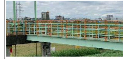
転落防止柵の嵩上げ
